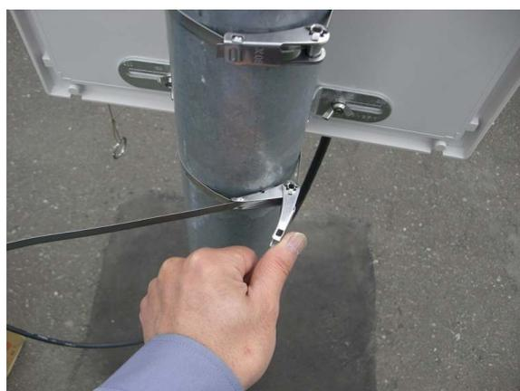
② 軸にバンドを巻き取るようにレバーを反復操作し
